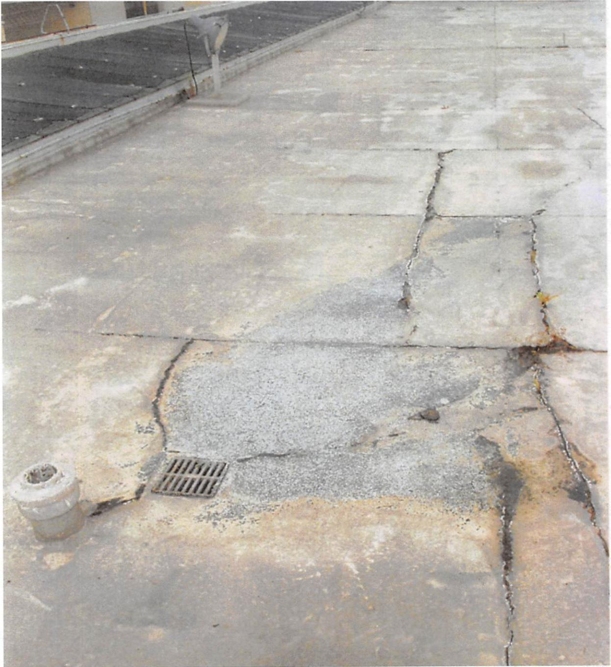
PMB HELOPAD ROOF/SURFACE IS CRACKING/THIS DRAIN IS THE ONLY ONE WITHOUT WEEDS
