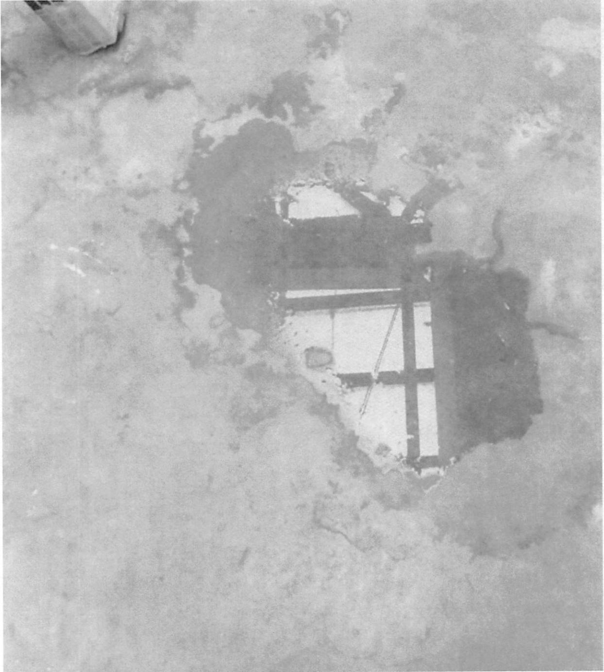
PMB SKYLIGHTS EAST AROUND MEZZANINE LEAKING
